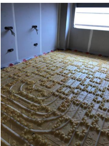
Montaje de suelo radiante en obra
