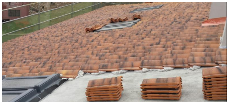
Tejado en construcción
